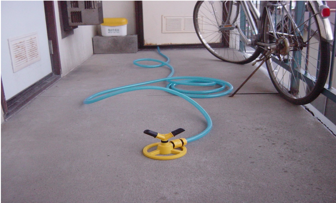
スプリンクラーの接続状況
